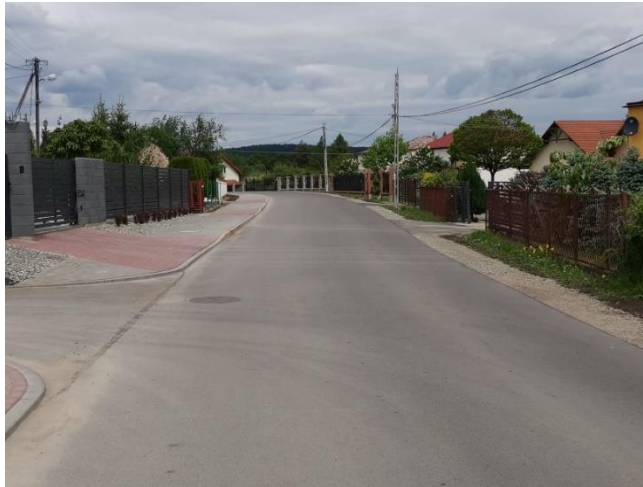
Droga gminna nr 116470R w Ostrowie.
