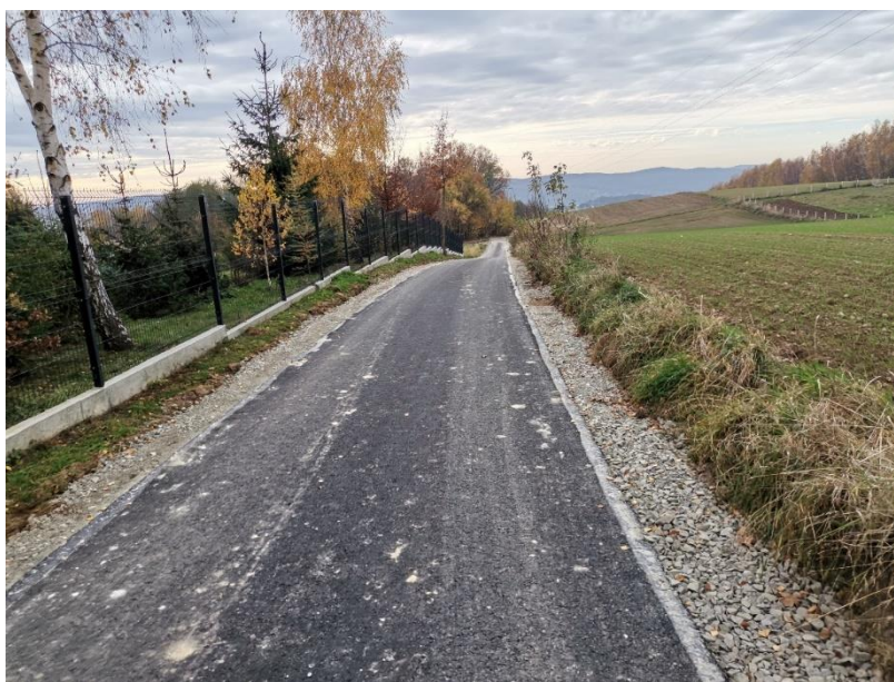
Droga wewnętrzna w Kuńkowcach.
