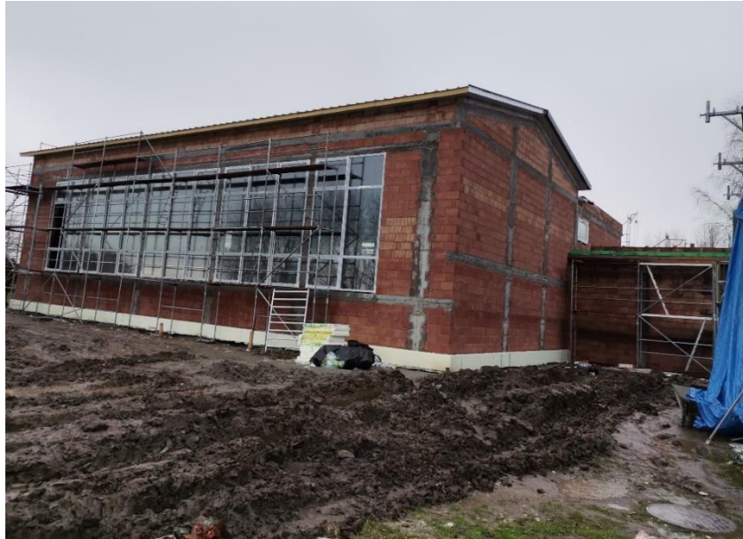
Budowa Sali gimnastycznej przy Szkole Podstawowej w Krównikach
