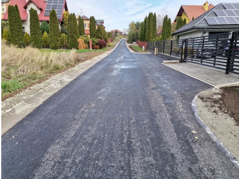
Droga gminna w Ostrowie.
