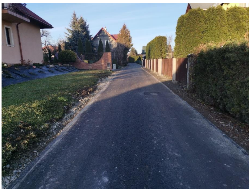
Droga gminna w Ostrowie
