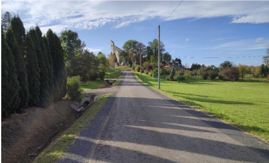
Droga Ujkowice Fort – Kościół
