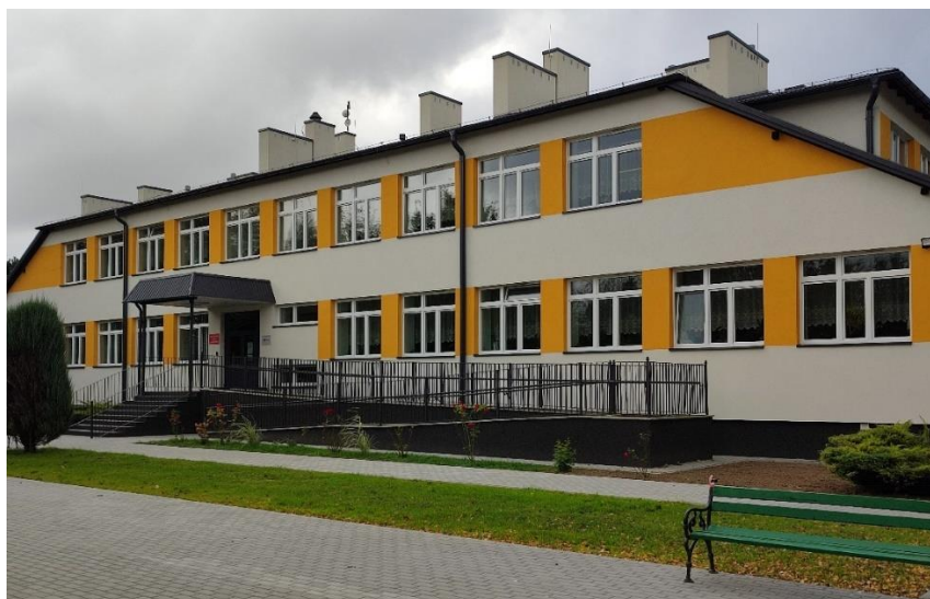
Szkoła w Krównikach po termomodernizacji
